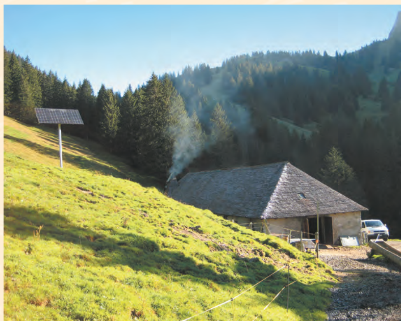
Panneau solaire alimentant en électricité un chalet d'alpage
