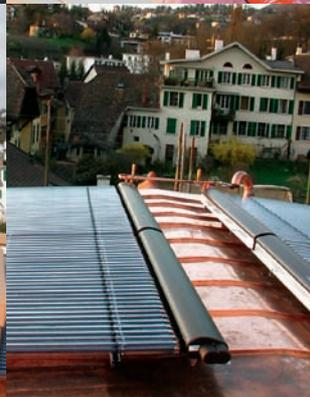
Champ solaire: pose de 2x6 m<sup>2</sup> de capteurs à tubes sous vide.
