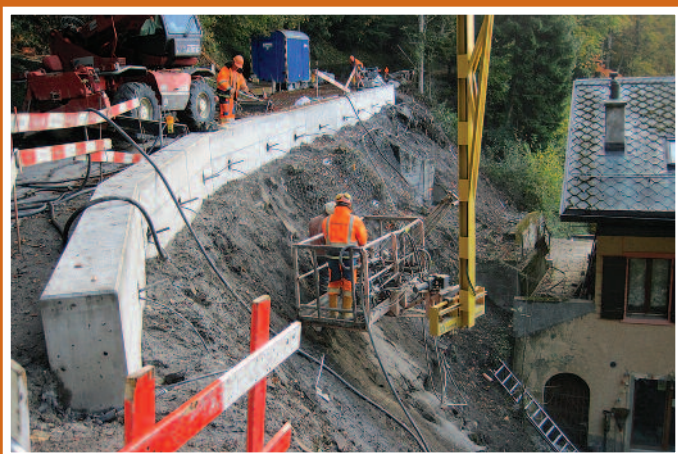
Ouvrage de soutènement à la route de Sonchaux.
