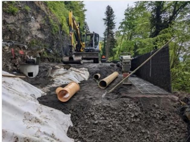
Travaux sur la fondation de la chaussée et stabilisation de l'accotement
