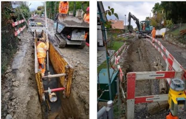
Réalisation de fouilles en tranchée et mise en place de réseaux souterrains
