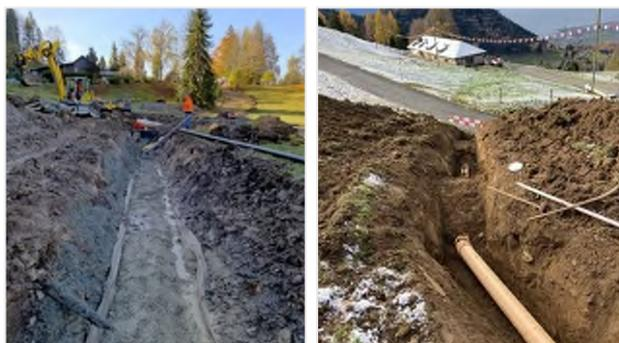
*Fouille avec mise en place d'une canalisation*
