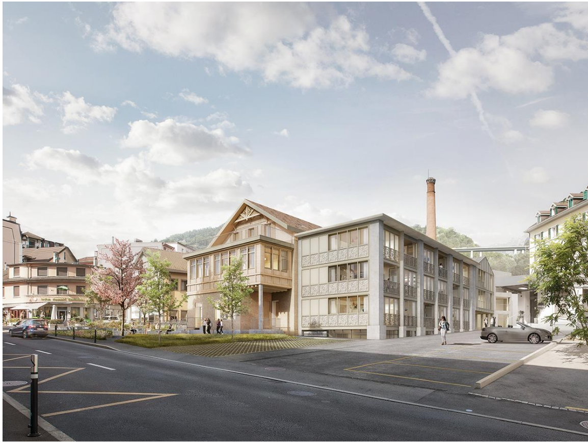
Images de synthèse du projet « Rives de la Baye » Steiner SA Copyright RDR architectes
