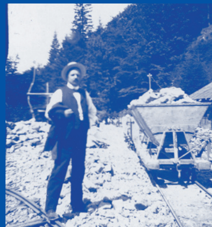
Illustration 9. Chantier de construction de la ligne du MOB, env. 1900
