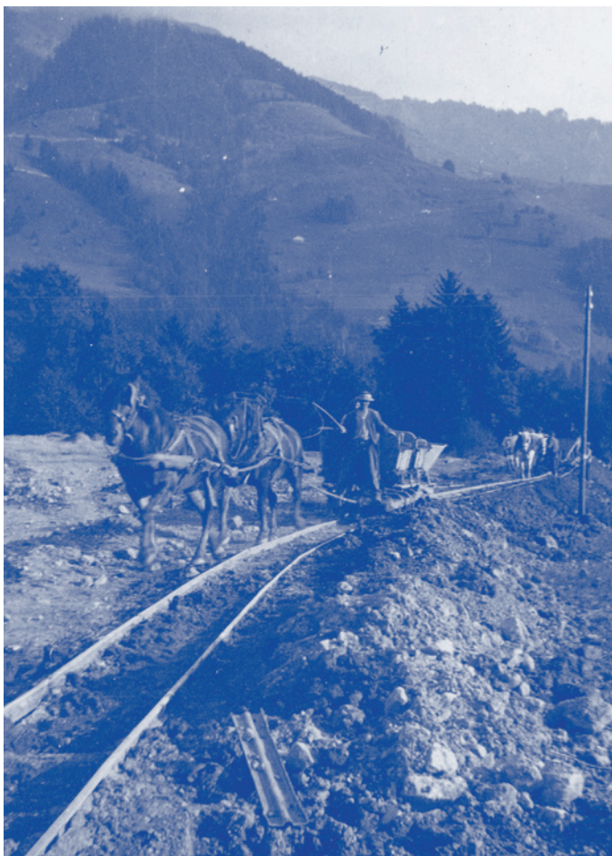
Illustration 7. Les ouvriers à l'œuvre sur le chantier du premier tronçon du MOB, env. 1900
