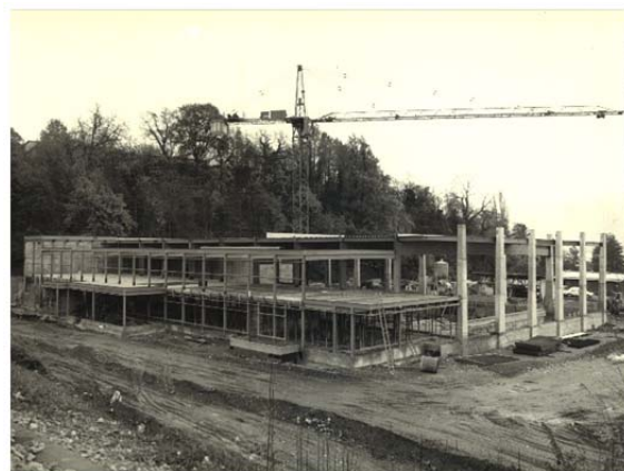
Fig. 7. Photographie noir et blanc de la construction de la piscine de la Maladaire, 1975-1977. Commune de Montreux, Gestion du territoire, Photographies et maquettes, MTX-G-i-0003
