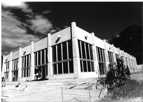
Fig. 8. Photographie noir et blanc des façades Sud et Ouest de la piscine de la Maladaire, 1976-1977. Commune de Montreux, Gestion du territoire, Photographies et maquettes, MTX-G-i-0003
